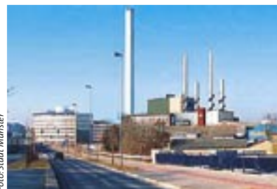
Gas- und Dampf-Heizkraftwerk in Münster
