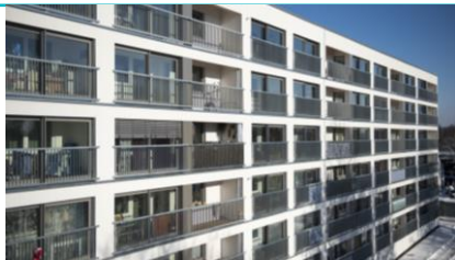
Mehrgeschossiges Wohngebäude, Augsburg Latke Architekten BDA, Gumpp & Maier GmbH
