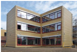
Waldorfschule Märkisches Viertel, Berlin Anton Ambros GmbH, TES EnergyFacade Bildquelle: https://www.ambros-haus.de/schulsanierung-waldorfschule-berlin.html
