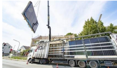
Quelle: Tamara Pribaten/dena
