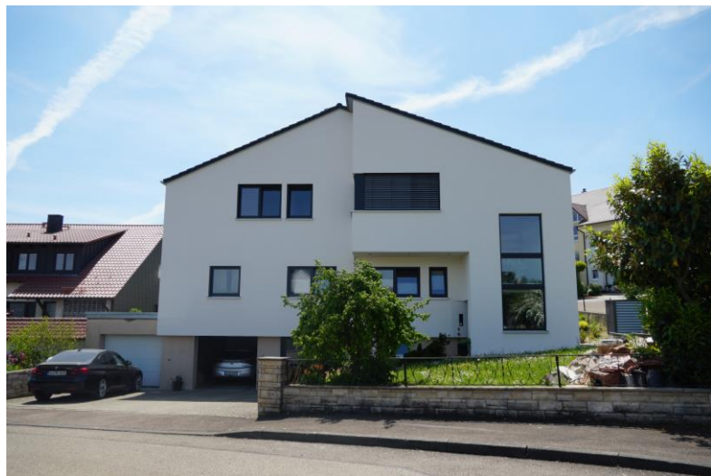
Zweifamilienhaus, Baden-Württemberg Sanierung und Umbau mit vorgefertigten Elementen Holzrahmenbau und Eigenleistungen Beteiligte: Taglieber Holzbau GmbH (u.a.) Bildquelle: dena_Energiesprung
