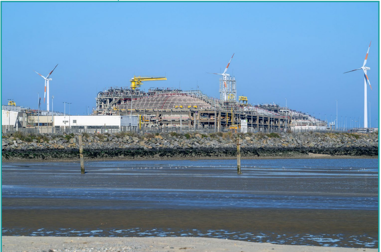
Fluxys LNG-Terminal in Zeebrugge
