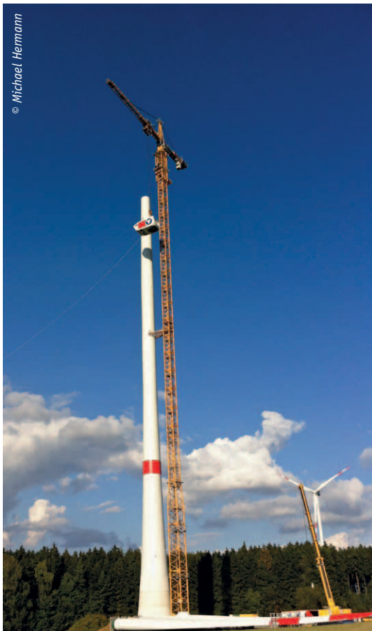
Errichtung der Windenergieanlage Stemmasgrün/ Fichtelgebirge
